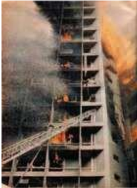
Figura 6 – Propagação por convecção, em que gases quentes fazem com que ocorram focos de incêndio em andares distintos
