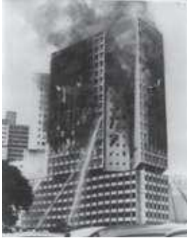
Figura 5 – Propagação por condução (contato direto das chamas)
