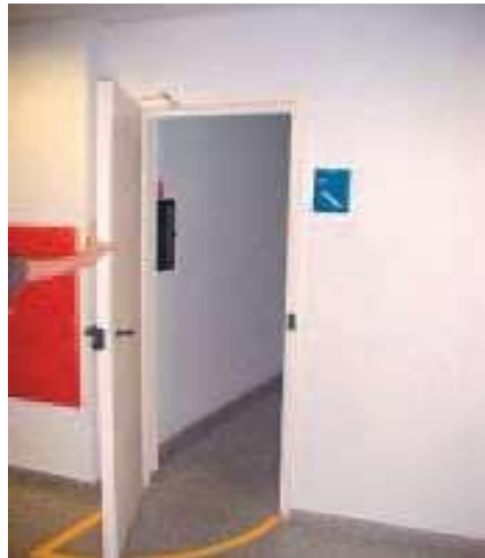
Figura 29 – PCF em corredor
