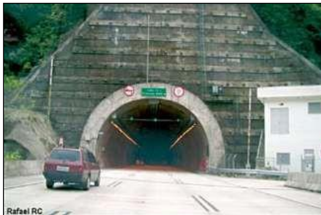
Figura 2 – Sinalização na entrada do túnel
