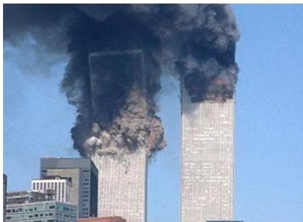
Figura 20 - Colapso estrutural - World Trade Center (Fonte: Rede mundial de computadores)
