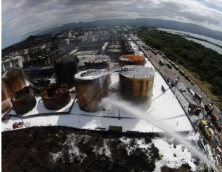
Figura 45 - Incêndio em parque de tanques
