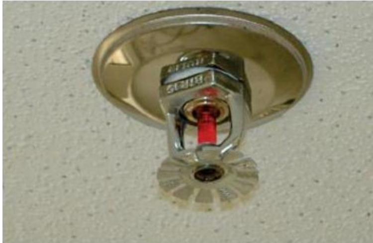
Figura 43 - Chuveiro automático
