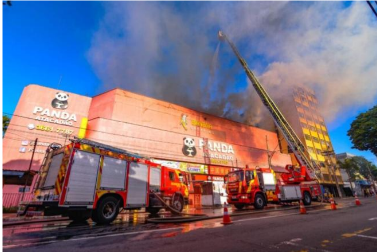
Figura 31 - Acesso à fachada frontal da edificação
