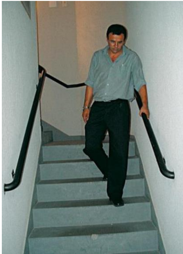
Figura 23 - Escada com largura apropriada para saída das pessoas
