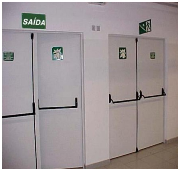
Figura 30 - Porta com barra antipânico
