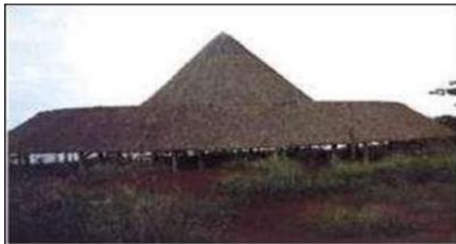
Figura 1 - Edificação de madeira com cobertura de fibras vegetais
